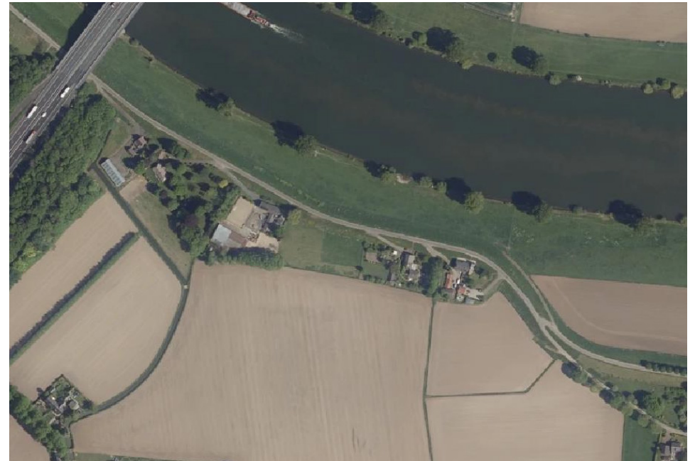
Figuur 3.42 - Luchtfoto dijkvak 37
