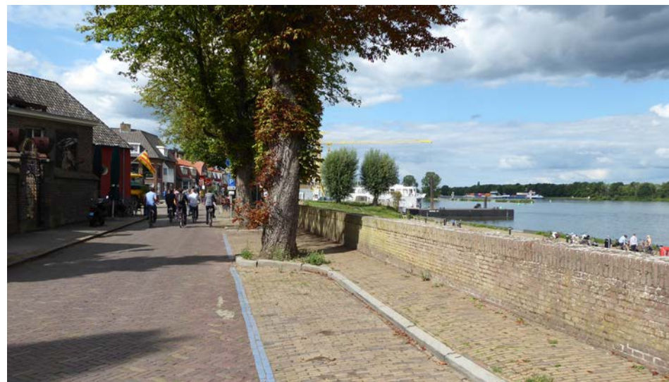
Figuur 3.24 - Huidige situatie Maaskade
